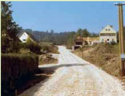
Die neue Trasse vom Haus Aumair bis Neubau Pflüglmayr
