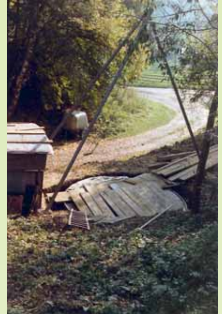
Bau des Versorgungsbrunnens in Mauer für die neue Wasserversorgungsanlage Wallern (ausführende Firma Schierl & Sohn, Schwanenstadt)
