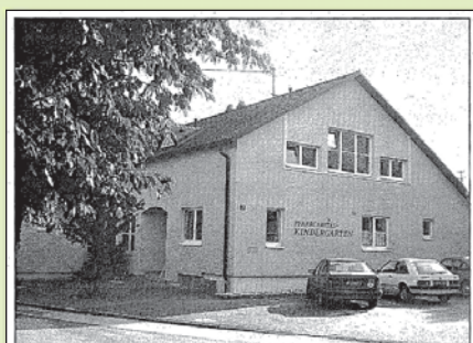
In kürzester Zeit wurde das Dachgeschoß des Gemeindevorschulkindergartens in Trockenbauweise ausgebaut.
