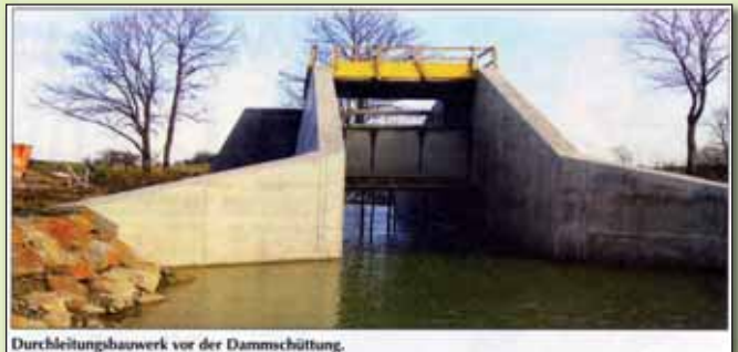
Durchleitungsbauwerk vor der Dammschüttung.
