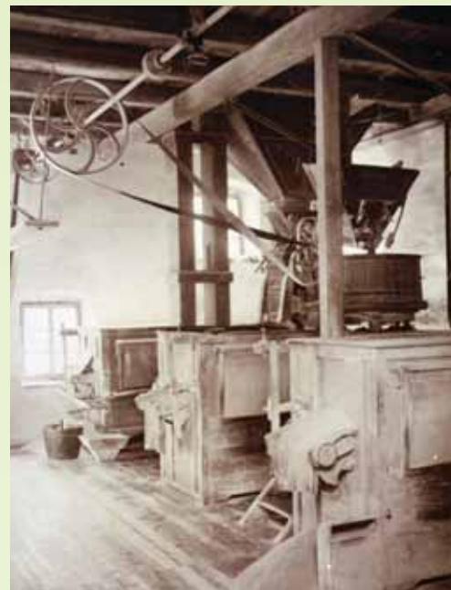
Der Mühlenraum - im Hintergrund ein Ganswalzenstuhl und ein Mühlstein mit Holzzarge. Davor 2 Beutelkasten, die Vorgänger der Mehlzylinder und Plansichter
