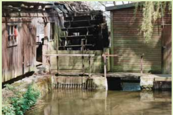
Die Mühle wurde 1960 stillgelegt. Die Säge etwas später. Der Antrieb erfolgte mit einem mittelschlächtigen Wasserrad
