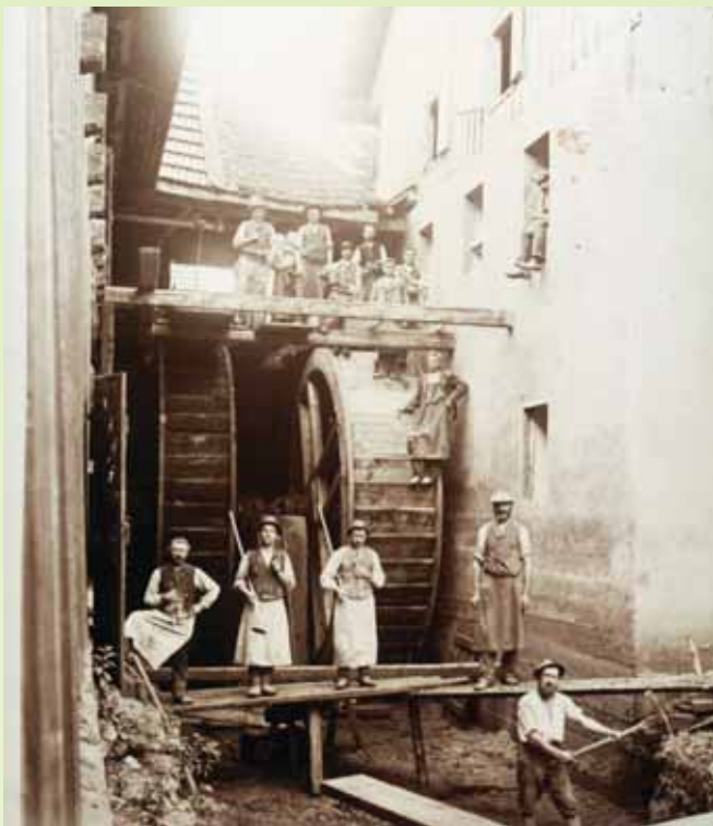
Ein rares Bild aus der Müllergeschichte. Ein doppeltes ober-schlächtiges Wasserrad wird eingebaut. Die Fachleute, genannt „Mühlenzurrichter“ bei der Fotopause
