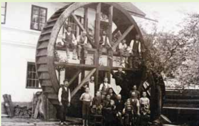
Der Neubau des overschlächtigen Wasserrades im Jahr 1925
