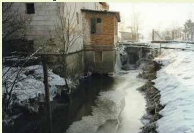
*Turbinenhaus mit Wasserüberlauf. Die hier laufende Turbine lief früher in der Mühle zu Furth und ist nach wie vor in Betrieb. Rechts stand die Säge.*
